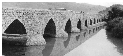
تصویر ۱۷- بالادست بند امیر در زمان پرابی و سرریز آب. منبع: (پایگاه میراث جهانی تخت جمشید، ۱۳۸۰)
